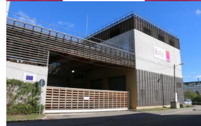
Centrale thermique rue Victor
