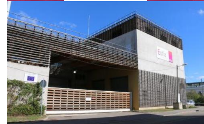
Centrale thermique rue Victor
