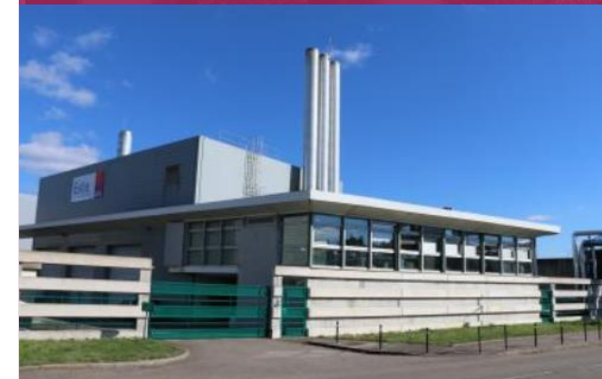
Centrale thermique rue Florentin
